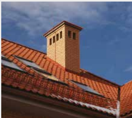
Кирпичные дымовой и вентиляционный каналы на крыше
