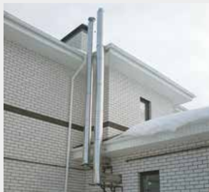
Приставные вентиляционный и дымовой каналы из нержавеющей стали
