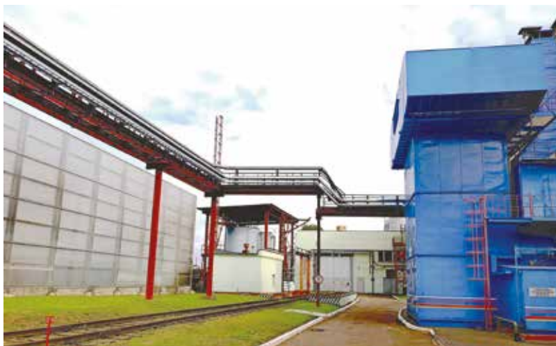
Рис. 1. Отражающий экран воздухоочистительного устройства (слева) ГТУ Лидской ТЭЦ
