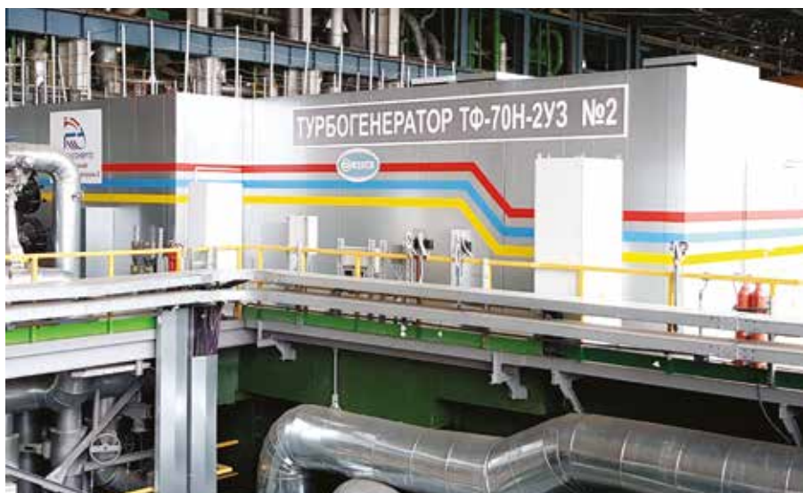
Рис. 2. Шумозащитный кожух турбоагрегата ТТ-70 Гродненской ТЭЦ-2
