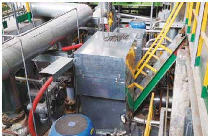
Рис. 3. Шумозащитный кожух конденсатного насоса турбины Гродненской ТЭЦ-2
