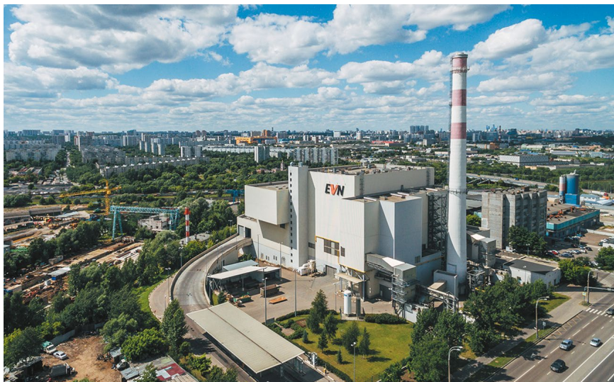
Рис. 1. ЕФН-Экотехпром МС3 3 (МС3 № 3)
