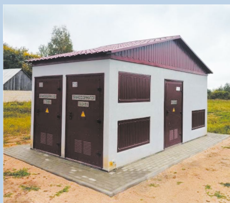
Рис. 2. Компоновка ЩУЭ после реконструкции электросетей 0,4–10 кВ в д. Старые Шуневцы
