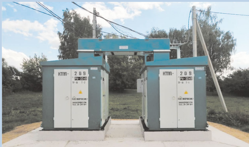
Рис. 4. Двухтрансформаторная КТПП в д. Торчилово
