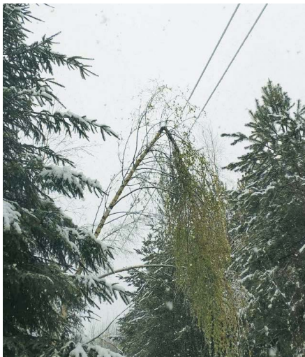
После падения деревьев на провода ВЛП 10 кВ линия остается в работе
