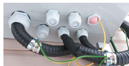
Уплотняющие устройства в местах прохода кабельных линий
