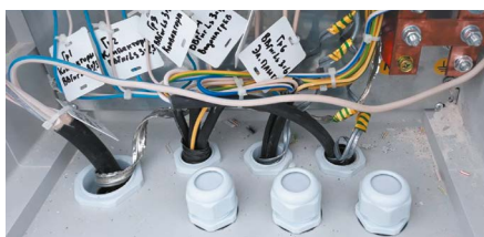
Уплотняющие устройства в местах прохода кабельных линий
