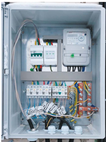
Присоединение PEN-проводника питающей линии к РЕ-шине нулевого защитного проводника
