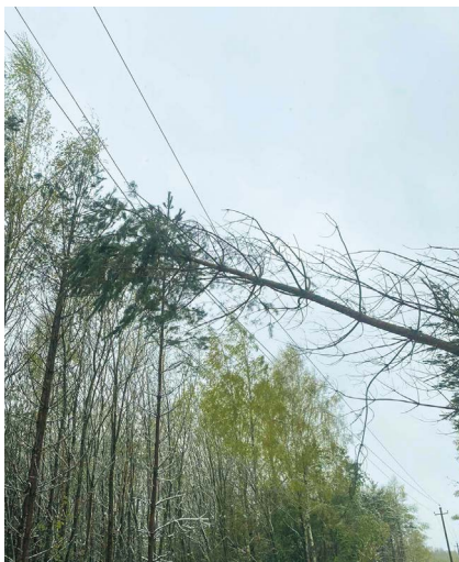
После падения деревьев на провода ВЛП 10 кВ линия остается в работе
