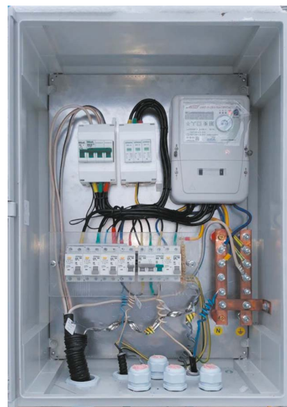
Присоединение PEN-проводника питающей линии к РЕ-шине нулевого защитного проводника
