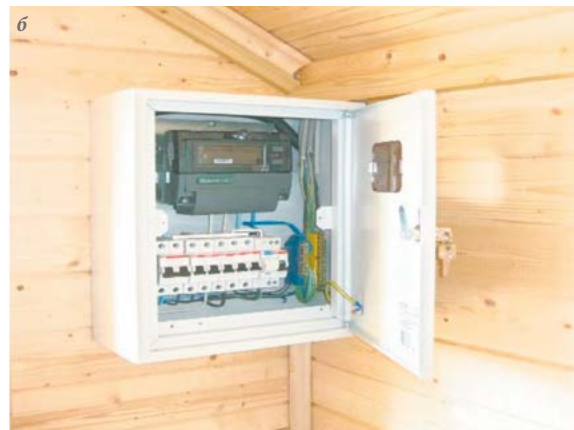
Рис. 1. Схема электроснабжения (а) и электрощит (б) дома с применением трехпроводной электропроводки и УЗО
